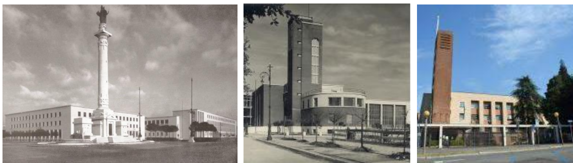
Da sinistra a destra: piazza della Vittoria a Forlì, la ex Casa della G.I.L. a Forlì, la facoltà di Ingegneria a Bologna
