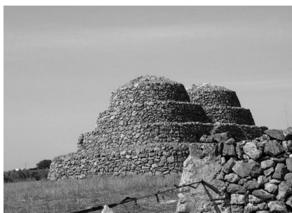
Fig. 10 – Architetture di pietra bicellulari, Maruggio
