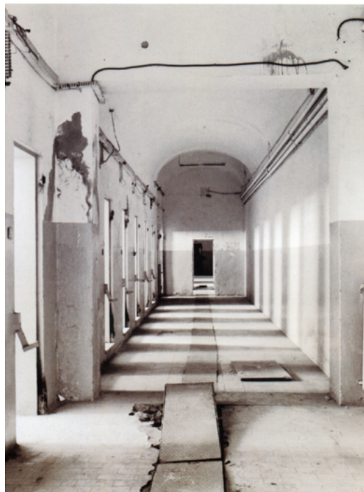
Fig. 34 - Bologna, carcere dismesso di San Giovanni in Monte, il loggiato superiore del chiostro piccolo prima dei restauri, ingressi alle celle di isolamento (da Scannavini 1996).
