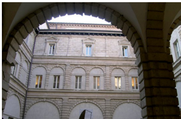
Fig. 19 - Bologna, complesso di San Giovanni in Monte, chiostro piccolo, "alla rustica".
