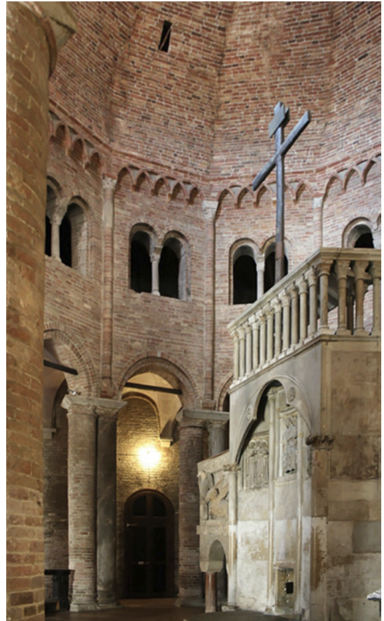
Fig. 4 - Bologna, complesso di Santo Stefano, chiesa del Santo Sepolcro, interno.
