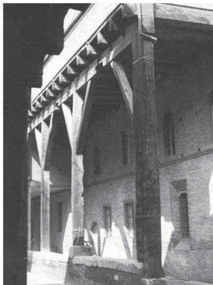
Anche sotto l'aspetto strutturale il portico è l'elemento caratterizzante dell'edificio dei Nuovi Istituti di Matematica e Geometria: Il basamento, formato più da setti variamente forati con ridotti passaggi, più che da pilastri, rimandano alla presenza nella piazza dell'antica porta San Donato (o porta Zamboni) della terza cerchia di mura (1300).
