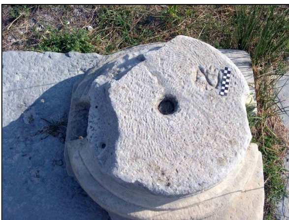
Fig. 20h, Kos, Basilica di S. Gabriele, marchio di bottega in forma di monogramma sul letto di attesa di una base di colonna
