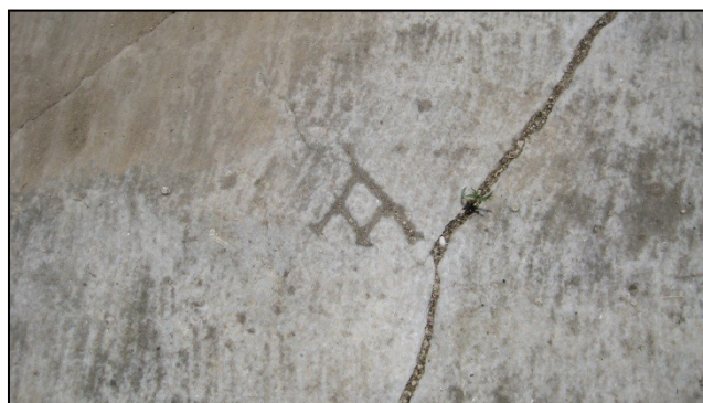
Fig. 25, Amphipolis, Basilica E, il marchio di identità A ricorre sulla maggior parte delle lastre dello stilobate e della pavimentazione dell'atrio
