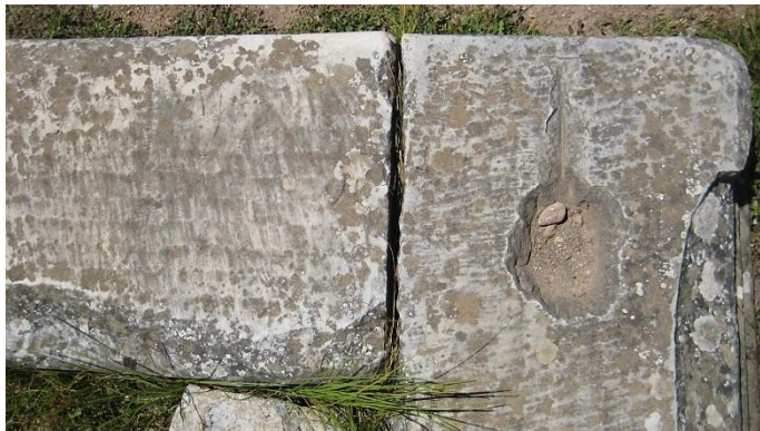
Fig. 11, Philippi, Basilica A, marchi di montaggio dei blocchi dello stilobate
