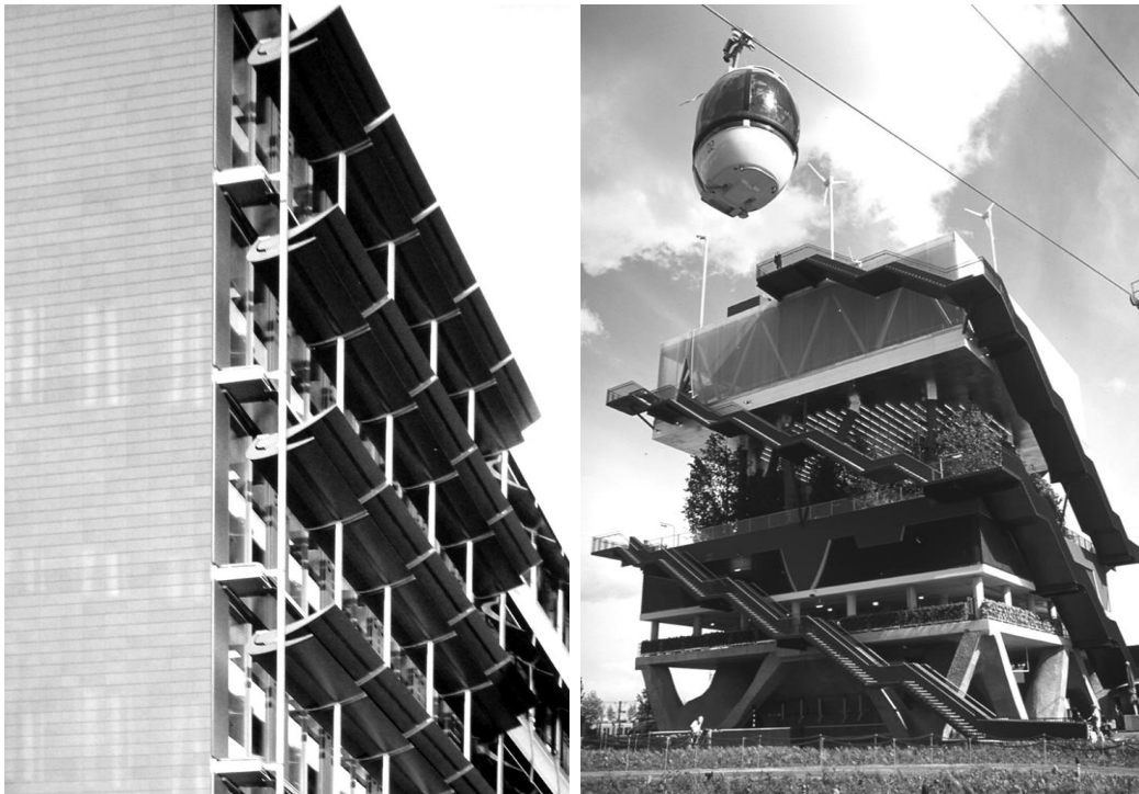
Figg. 1.50, 1.51 – A sinistra, Thomas Herzog, frangisole mobili nell’Administration centre for the Supplementary Pension Fund of the Building Industry SOKA-BAU a Wiesbaden, 1994-2003. A destra, MVRDV, padiglione olandese all’Expo di Hannover del 2000: il linguaggio dell’architettura si poneva come filtro attraverso cui prospettare nuove soluzioni ai problemi dell’inquinamento, dell’esaurimento delle risorse naturali, della congestione e della vivibilità dei centri urbani. La struttura del padiglione enfatizzava il rapporto naturale-artificiale sovrappo- nendo sei modi di essere del paesaggio: dalle dune del piano terra al polder della copertura.
