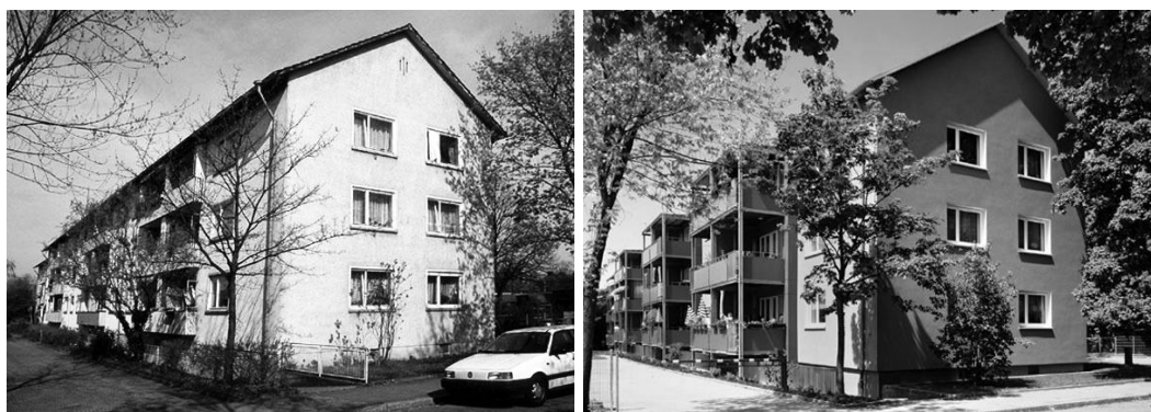
Figg. 1.55, 1.56 – Riqualificazione energetica di un edificio in Rislerstraße a Friburgo, con inserimento di un cappotto termico e di nuovi balconi in acciaio autoportanti, per ridurre i ponti termici.
