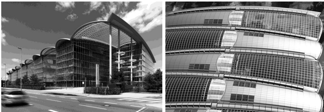
Figg. 1.44, 1.45 – Ingenhoven Architekten, Lufthansa Aviation Center, completato nel 2006. L’edificio richiede un terzo dell’energia di un edificio per uffici convenzionale. Nove giardini con essenze vegetali provenienti da tutti i continenti occupano una serie di grandi atri per il relax. Nelle zone di collegamento tra i sistemi di copertura alcune ali speciali stabilizzano la pressione del vento in modo da facilitare l’espulsione verso l’alto dell’aria di ricambio.
