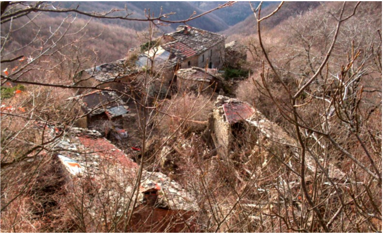
Fig.3-Chiapporato dicembre 2011. Dettaglio dello stato di decadenza di alcune strutture abitative.
