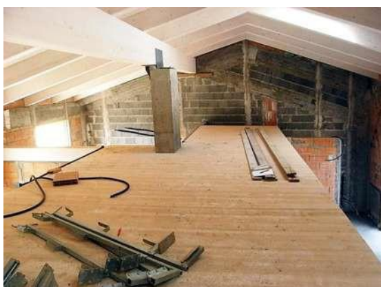
Soppalco e copertura in legno, Russi, 2011. Impianto e cappotto termico
