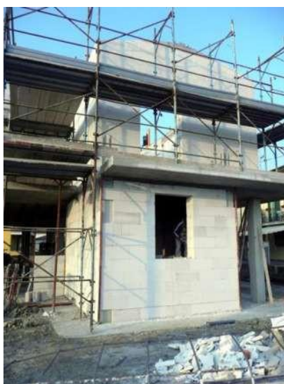
Edificio con struttura di c.a. e tamponamento in calcestruzzo cellulare, Fosso Ghiaia, Ravenna, 2008. Edificio con struttura di c.a. inserita in blocchi-cassero isolati, Russi.
