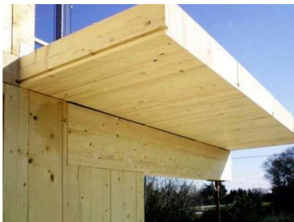
Struttura a sbalzo in x-lam, Forlì.
