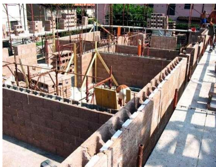
Edificio con struttura di c.a. e tamponamento in calcestruzzo cellulare, Fosso Ghiaia, Ravenna, 2008. Edificio con struttura di c.a. inserita in blocchi-cassero isolati, Russi.
