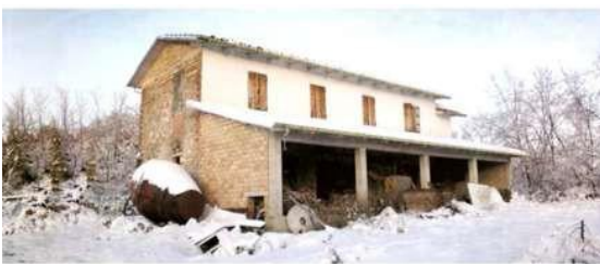
Recupero di edificio in pietra sopra Brisighella, 2011.
