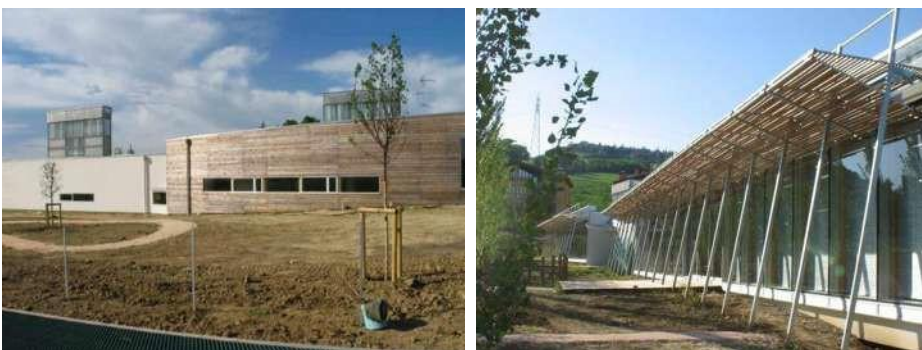
Edificio scolastico nei pressi di Imola
