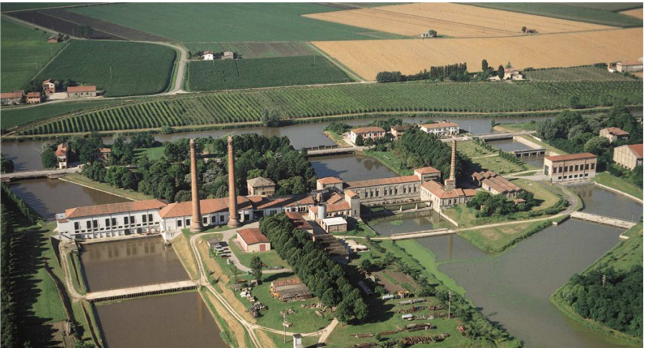
Fig. 36 Impianti idrovori di Codigoro, realizzati all'inizio del Novecento e negli anni '90, per gestire le acque alte, basse e intermedie, in Wikipedia Commons.
