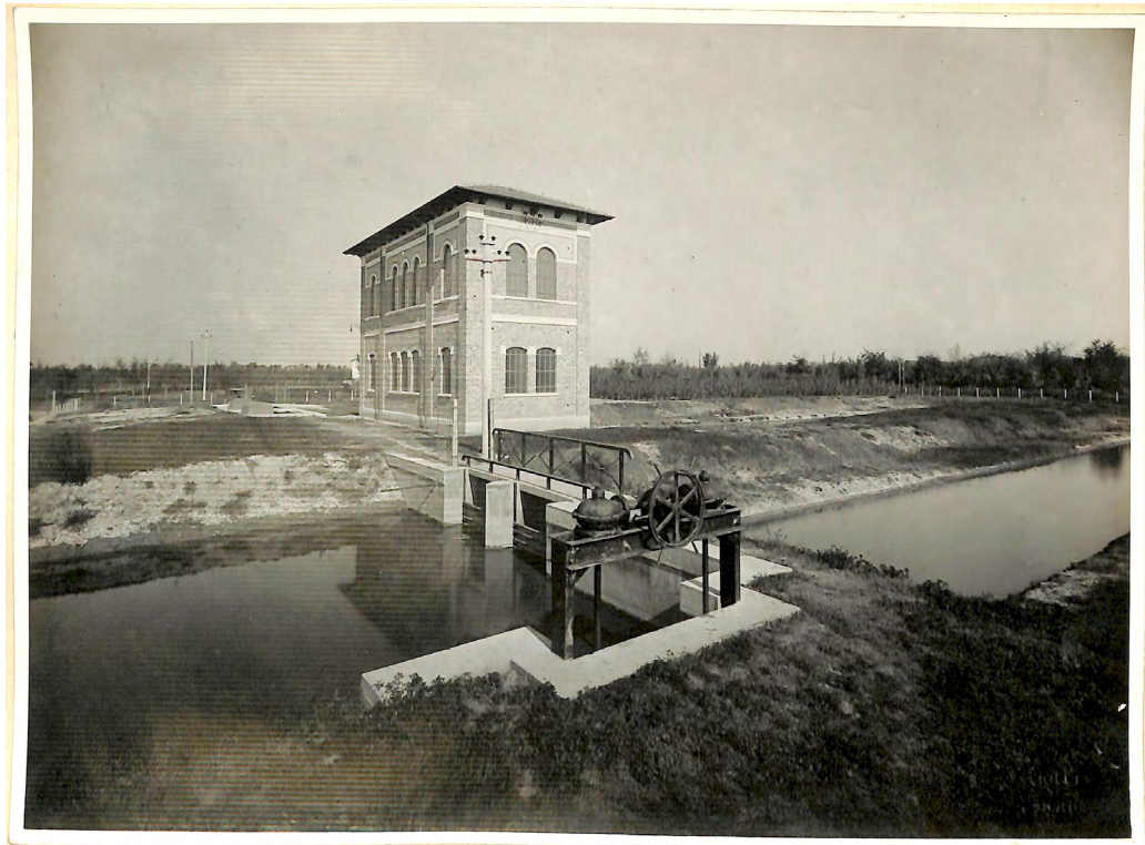
Impianto di sollevamento a "Mancasale"
