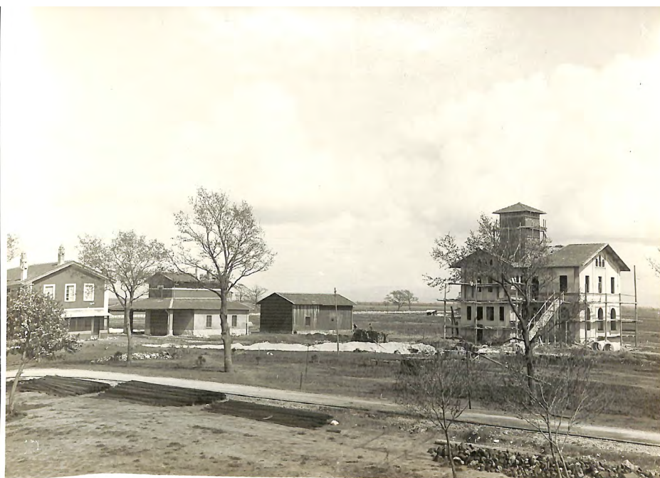
Bonifica di Piscinara: Villaggio operaio in costruzione
