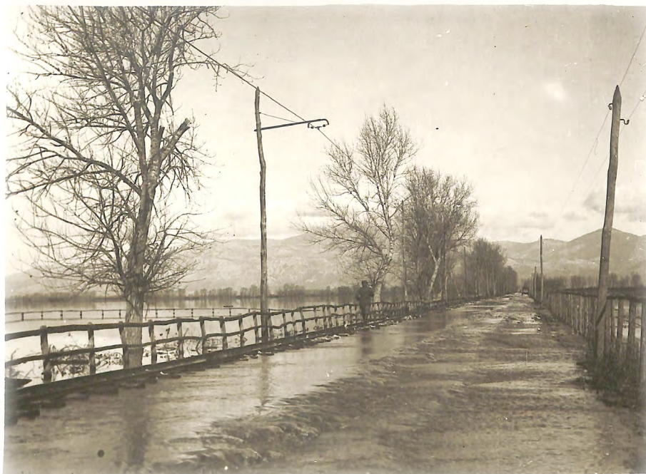
Bonifica di Piscinara: Piene del febbraio 1928
