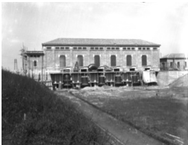
Fig. 7. L'impianto idrovoro di Saiarino in fase di completamento (febbraio 1925) (Archivio Consorzio Bonifica Renana).
