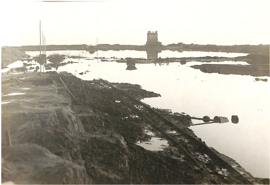
Sopra: Inondazioni presso Foce Verde Sotto: Escavo meccanico del Collettore Acque Alte
