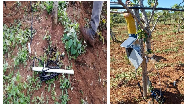
Fig. 2 (a) Sonde Sentek Drill & Drop in fase di installazione, (b) Sonde Sentek posizionate nel terreno e collegate al data logger.
