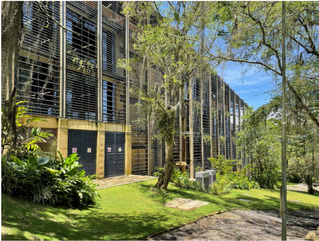
Fig. 9 | Fronte laterale permeabile e accessibile. (Luca Marzi, 2022).
