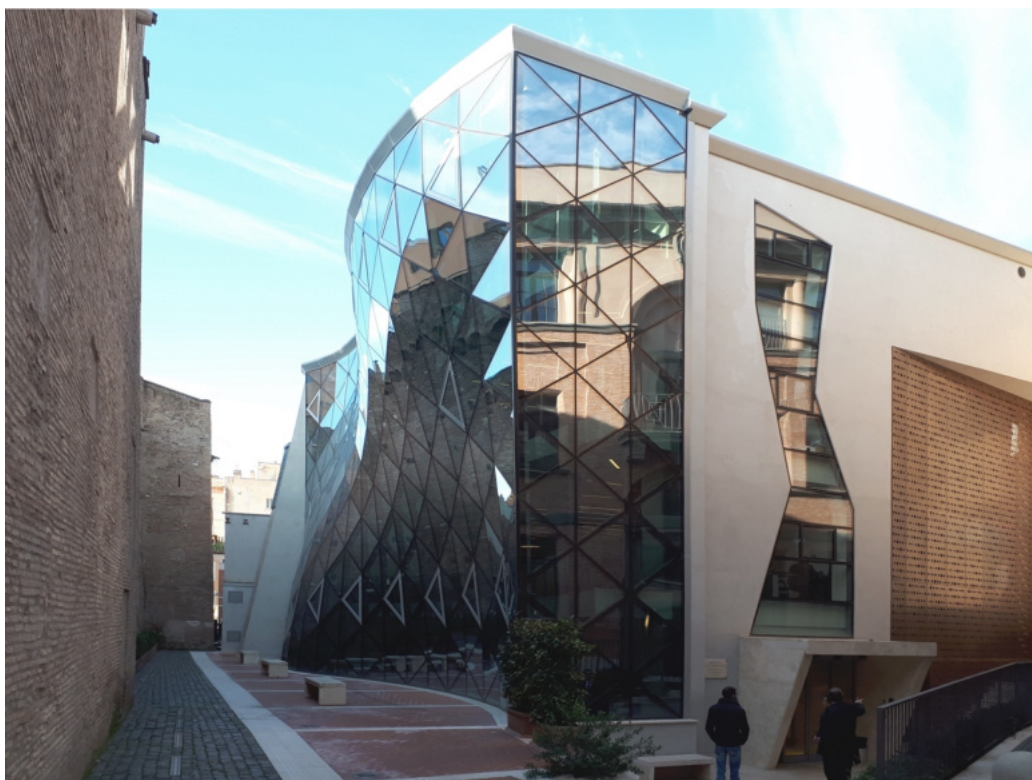
Fig. 1 | Facciata vetrata della Biblioteca LUMSA di fronte al Passetto di Borgo (Fonte: Archivio Centro TESIS)
