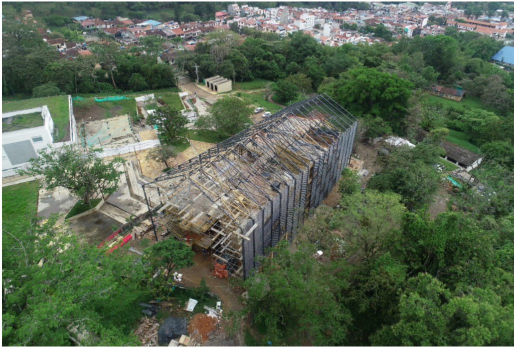
Fig. 3 | Edificio in costruzione. Vista dal drone (UIS, 2019).
