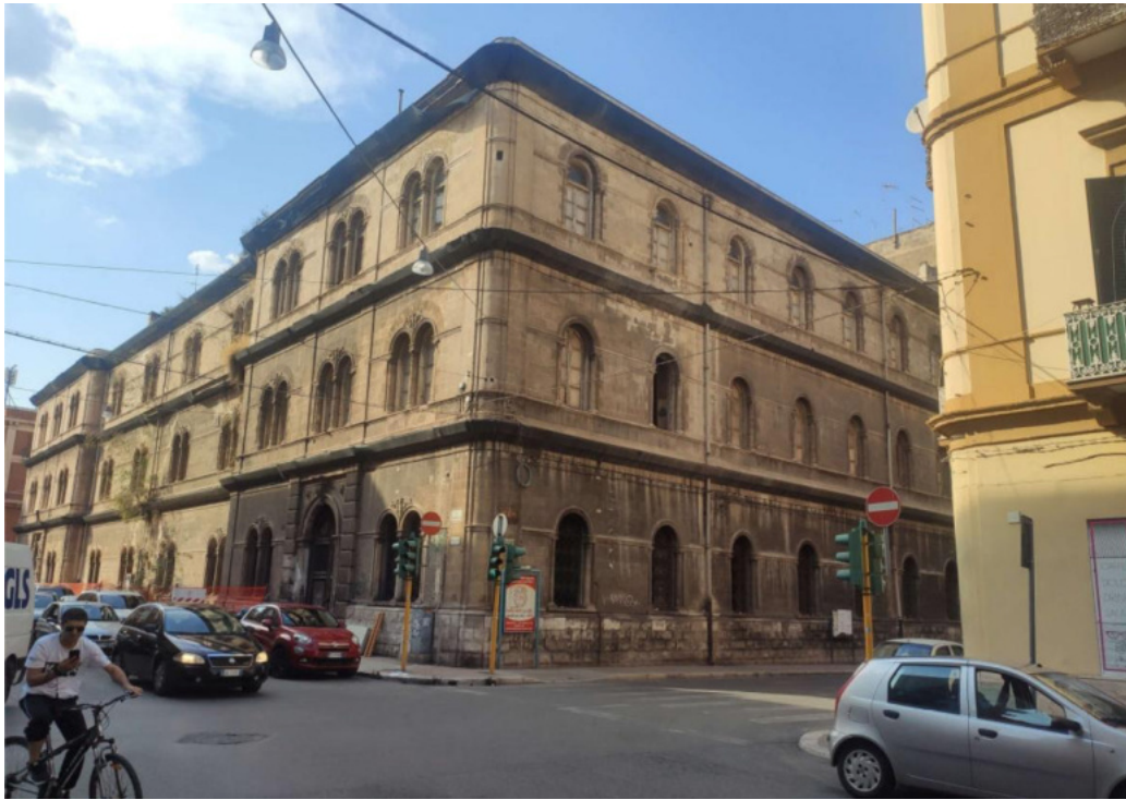
Fig. 1| Esterno di Palazzo Frisini, stato attuale.
