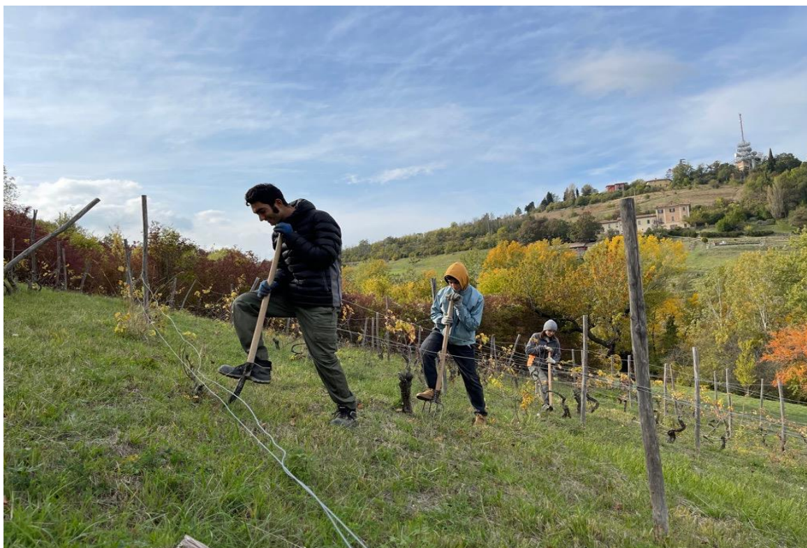
Lavori di ripristino del vecchio vigneto del parco di Villa Ghigi
