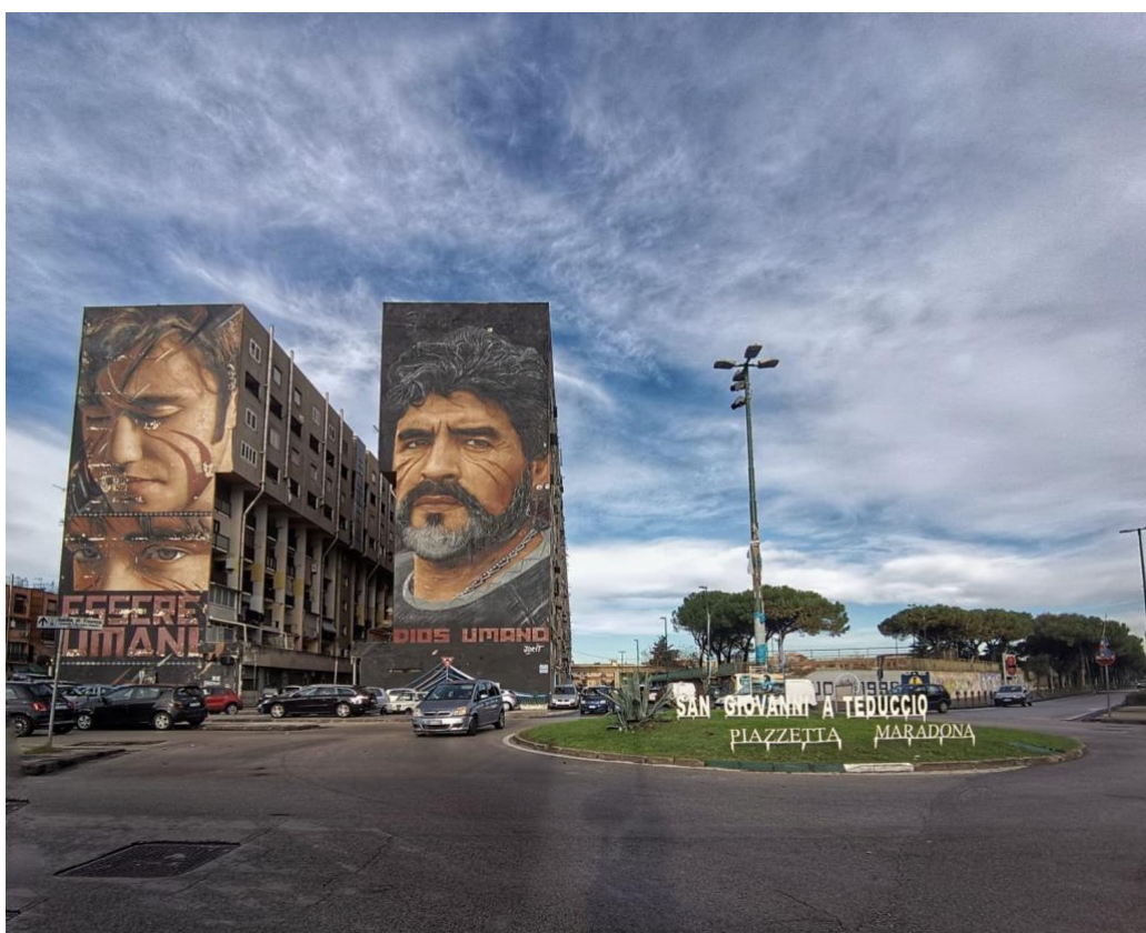
Fig. 1| Taverna del Ferro, San Giovanni a Teduccio, Napoli (2023). In foto le "stecche residenziali" Prima dell'intervento in corso. Foto di G. Arillotta
